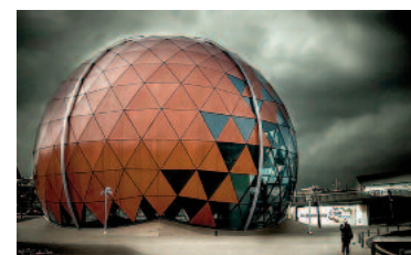
Capital Europea del Básquet (Badalona) Instaladas más de 1000 m 2 de losas SILENTFLEX para climatizadores bombas y transformadores
